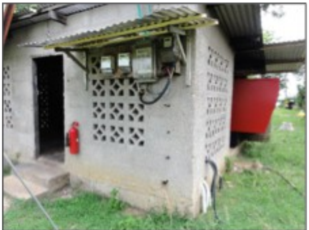
provisorische Energiemessung
