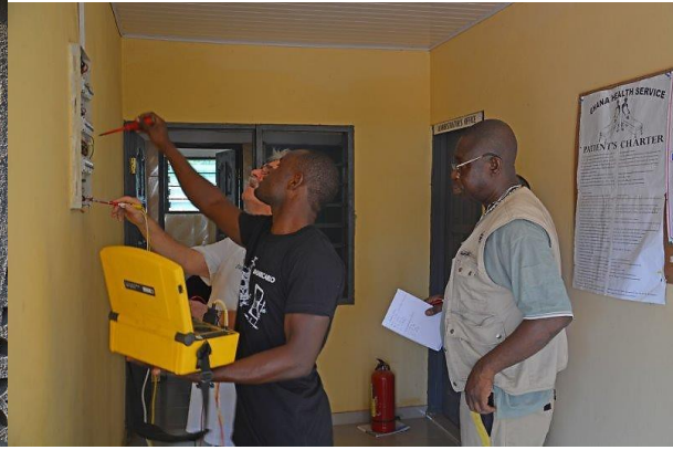
Kontrolle der inhouse - Installation
